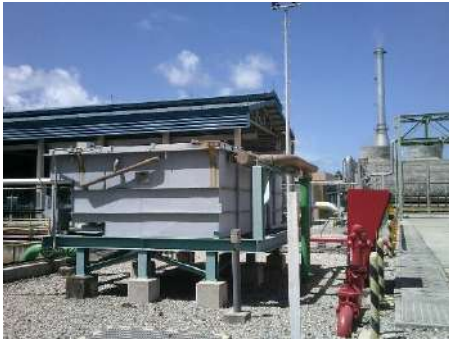
ภาพที่ 2.2-6 ถังแยกน้ำกับน้ำมัน
